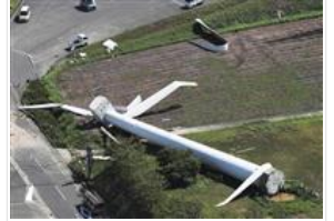
台風20号により倒れた風力発電の風車=8月24、兵庫県淡路市（本社ヘリから）
